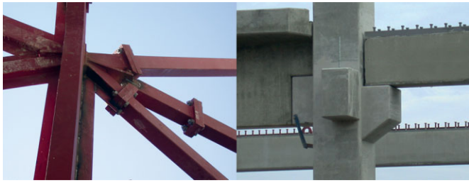
Bild 2 Standard im Stahlbau und Stahlbetonfertigteilbau: Fügen von Halbzügen (Profilen) aus industrieller Produktion [Foto KLOFT] Standard in steel and precast concrete construction: joining of semi-manufactured parts (profiles) of industrial production
